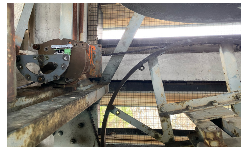
Fotos oben und links: Teile der erneuerten Glockensteuerung. Alle Fotos: Glockentechnik Bayerwald - Lang & Gruber
